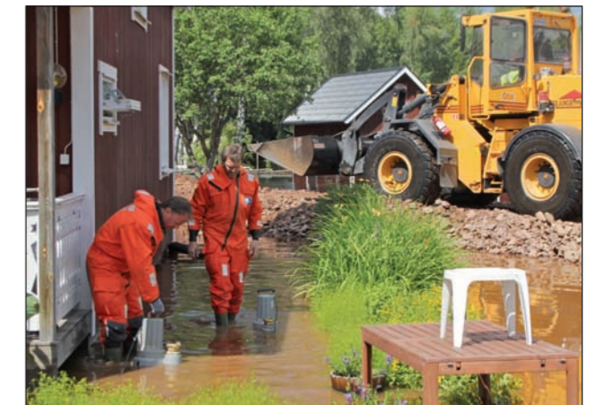
Dymatic TITAN Vortex läns-slampumpar. El-230 V Läns-pumpning översvämning, Hultsfred.
